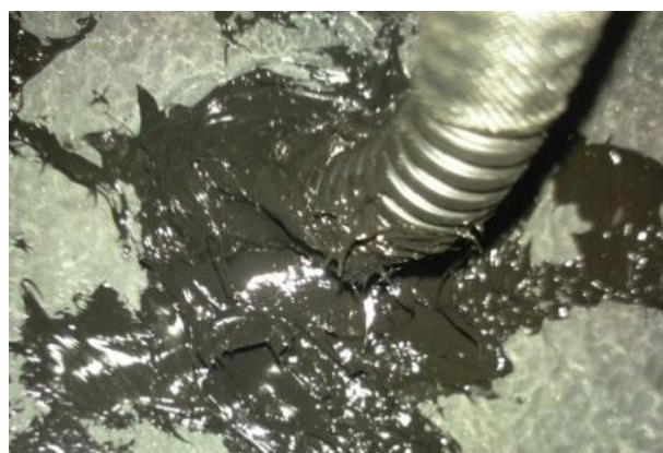
密封穿线孔：如图示意已涂密封胶（图片仅供参考）
